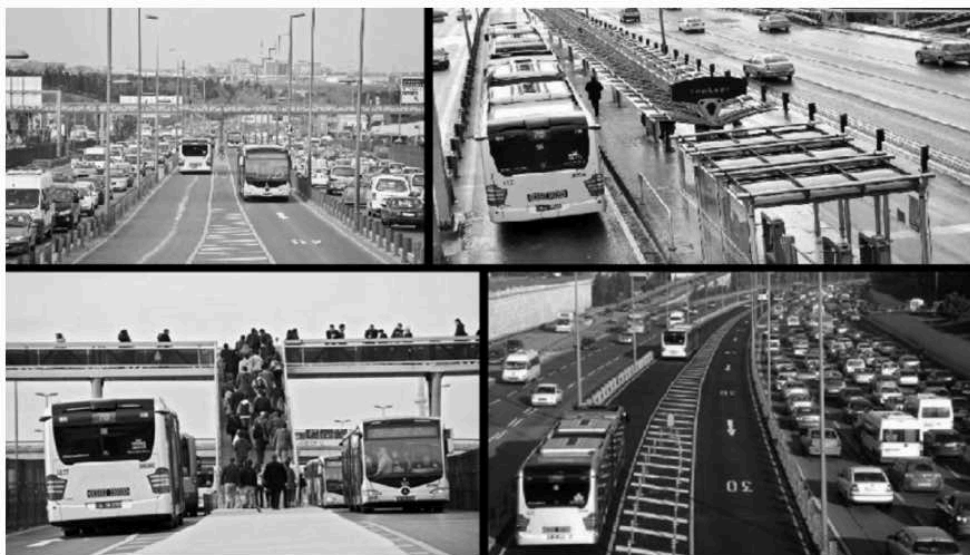
Figura 31: Metrobüs operando no corredor central exclusivo; plataforma central de embarque e desembarque e mão inglesa de sentido de circulação.
