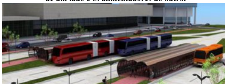
Figura 30: Projeção das estações tubo duplas, recebendo os ônibus biarticulados dos corredores troncais de um lado e os alimentadores do outro.
