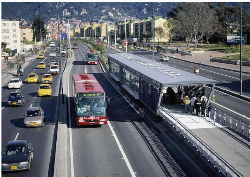
Figura 1: Sistema BRT TransMilenio de Bogotá, Colômbia.
