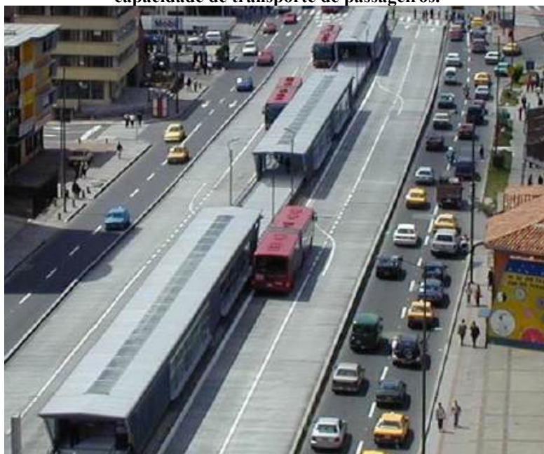
Figura 17: O uso de múltiplas estações de embarque permite ao sistema TransMilenio atingir alta capacidade de transporte de passageiros.
